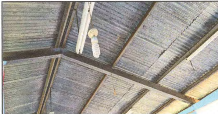
Foto 2: Mantenimiento de estructura de metal para mayor vida útil (lijado y pintado).
