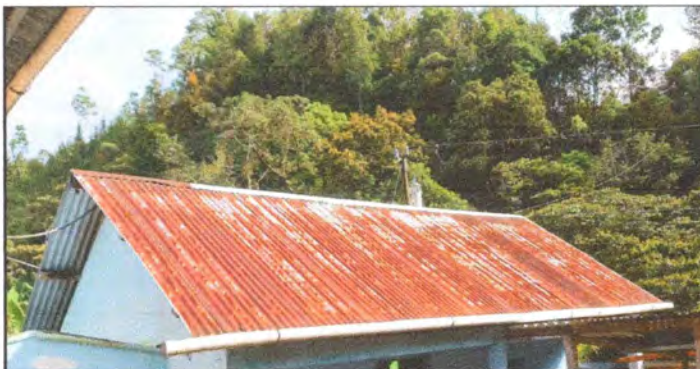
Foto 3: Sustitución de lámina acanalada por lamina troquelada en área de cocina.
